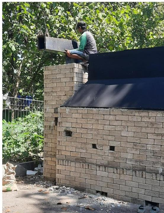
**Gambar 17. Konstruksi ruang pembakaran asap tanpa Sower**
